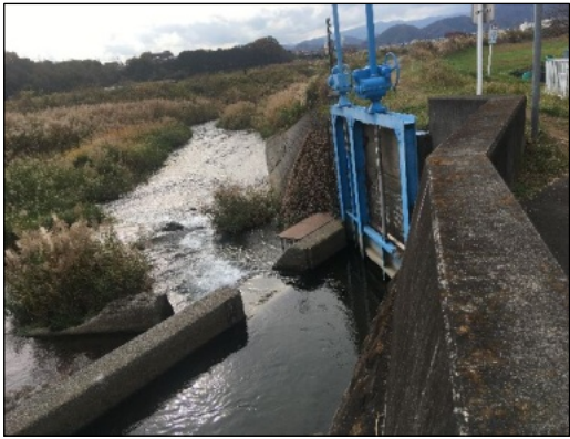
来光川にあるハツ溝用水の取水口
