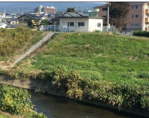
来光川の五反田橋北側にある揚水ポンプ場
